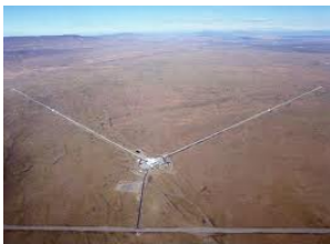
Abbildung: LIGO: 2 Interferometer in Nanford Washington und Livingston Louisiana 2 bzw. 4 km Armlänge, Duales Recycling
